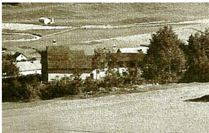
La Cornaz de bise vue de l'arrière en 1899. On est en train de construire le chemin de fer.
